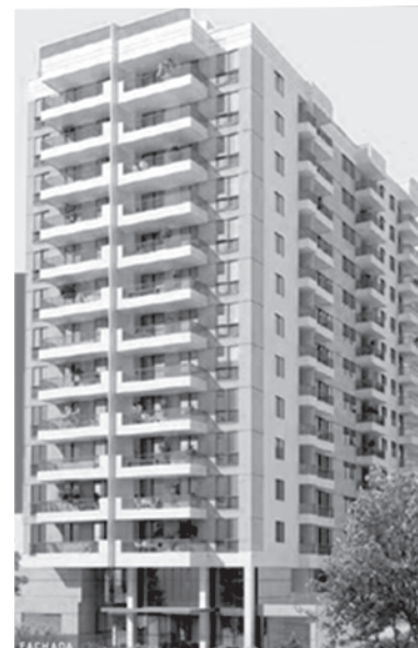
Figura 1 Fachada da edificação
