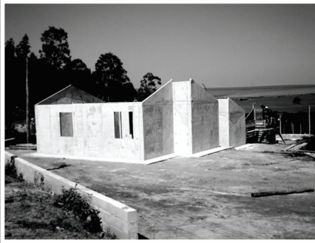
Figura 2 - Habitação com vedações concluídas (10)
