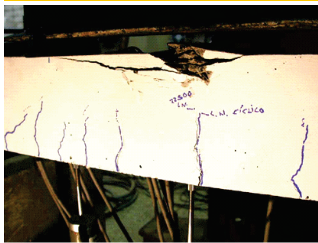
Figura 5 – Modo de ruptura das vigas do grupo II (VR-AD-CE)
