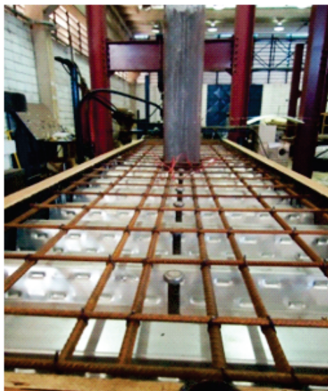
A Armadura da laje
